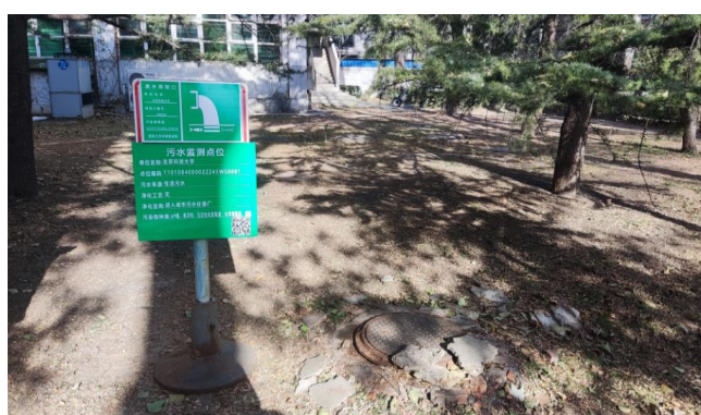
图 3 化粪池废水排口
